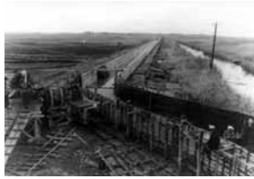
第3号揚排水機場工事
