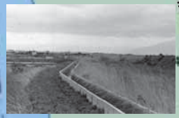
第1号幹線排水路
