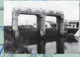
鳥谷川制水門
